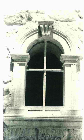
Παράθυρο. Νέα κατασκευή (Κουρέμπα).
